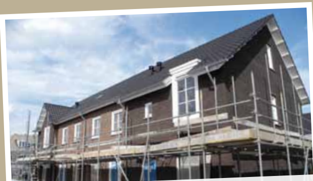
Tijdens het Open Huis op 13 juni start de verkoop van fase 3 van project 't Schaepserf. Op de foto fase 2 in aanbouw.
